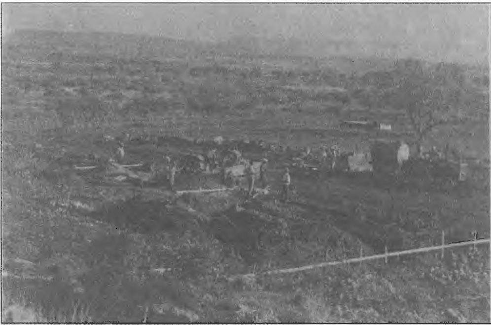
Uma panorâmica que dá ideia da beleza do lugar da nossa Aldeia. Em primeiro plano, imagem dos trabalhos de arranque do Bloco 2 da Casa-Mãe.
